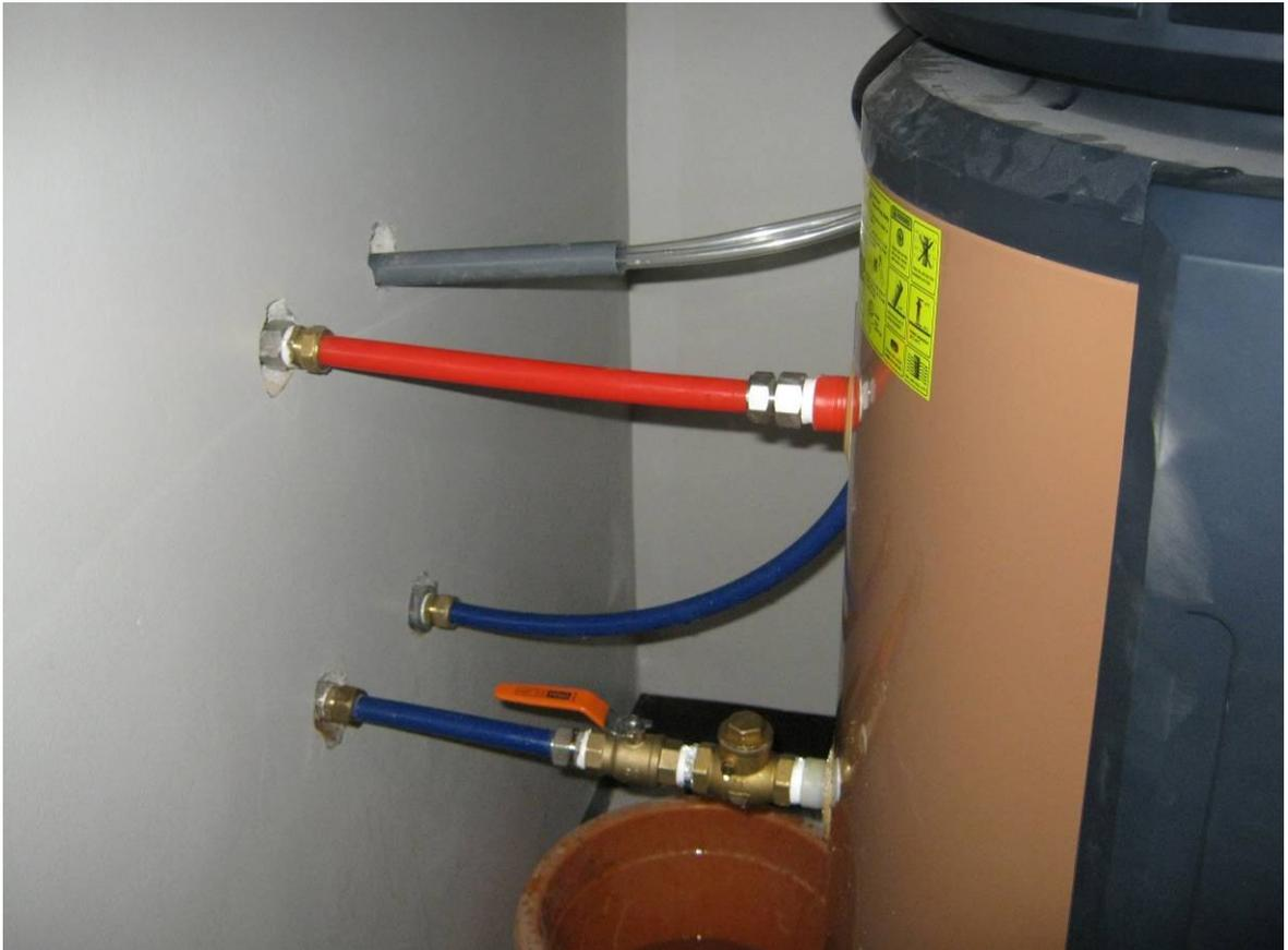
Catatan: tidak harus memakai flexible pipe, tetapi ini mempermudah pemasangan dan servis.
